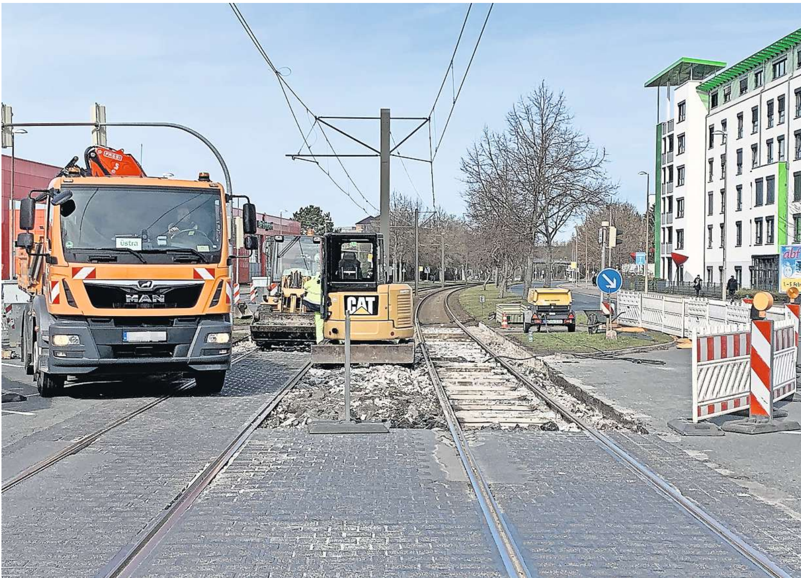
Zweite Baustelle auf der Erich-Panitz-Straße: Auf der Kreuzung zur Würzburger Straße wird die Gleiseindeckung erneuert.
