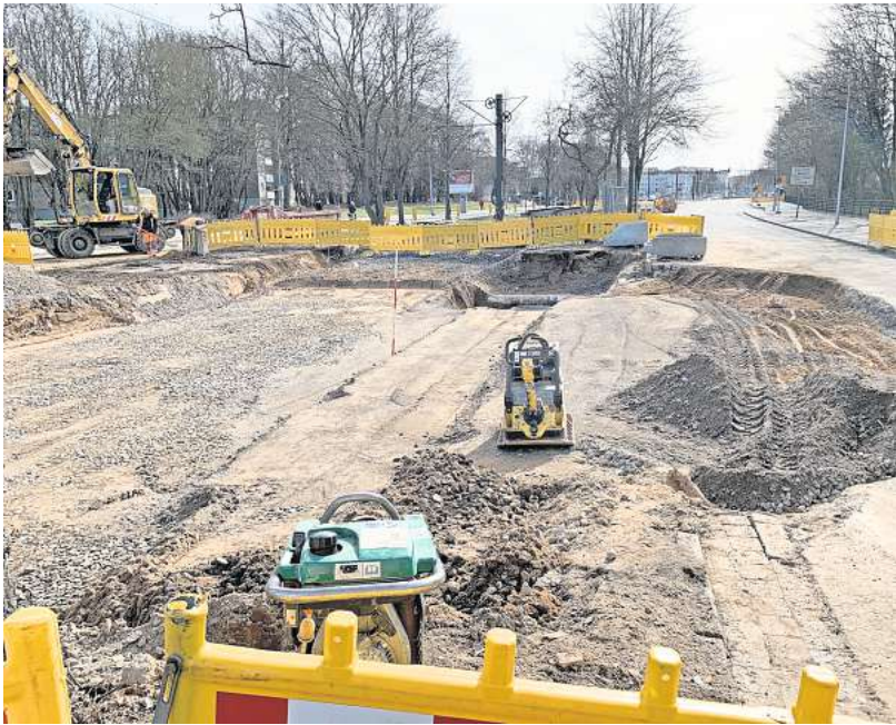
Arbeiten im Zeitplan: Der Bombentrichter ist weitestgehend aufgefüllt, ab Montag soll mit dem Wiederaufbau der Gleise begonnen werden.
