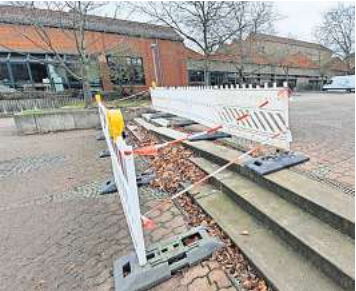
Die Betonstufen vor der AES sind verschoben, seitdem ein Autofahrer die Anlage heruntergerollt ist. FOTO: JOHANNES DORNDORF
